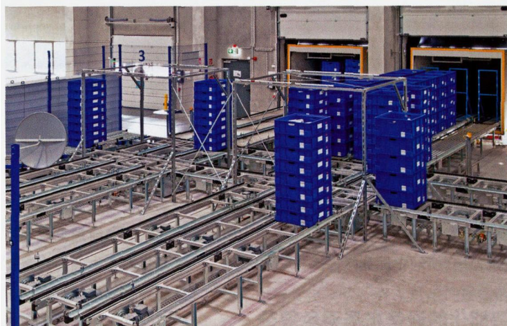
图 2 在载货汽车上，通过自动化输送技术装置来完成电缆端分线容器的装和卸作业
