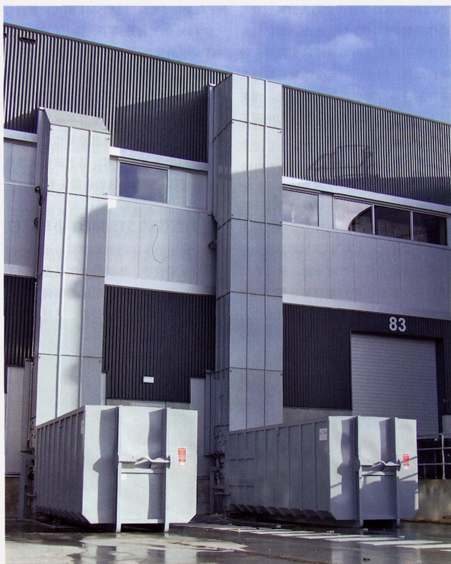
图 1 在两层楼高处，机械式举升 / 装卸设备接收容积为 2200 L 的垃圾容器
