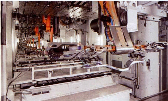
图3 横杆式机械手能够快速、准确地按照编程轨迹把钣金零件输送到压力机的正确位置上
