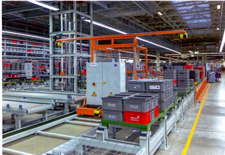
图2 Miele & Cie 公司扩展后的新输送生命线每日三班连续运行，该输送系统从安装连接到交付使用仅用了3个月的时间
