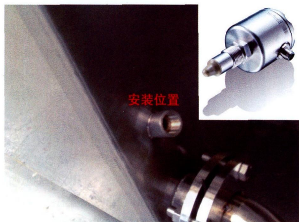
图2 CleverLevel LFFS 安装工位
