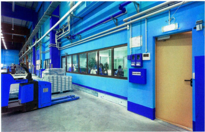
图 6 为了确保工业建筑物的防火功能,必须根据建筑物各个区段的具体风险状况,分类安装滞燃 (T30)、高度滞燃 (T60) 或耐火 (T90) 的钢制工业用门
