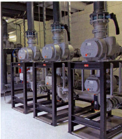
图2 由滑阀式真空泵和罗茨真空泵组成的中央真空系统为新鲜食品的真空包装提供所需的真空，真空泵所散发出来的废热被通风换气系统抽取用于建筑物采暖
