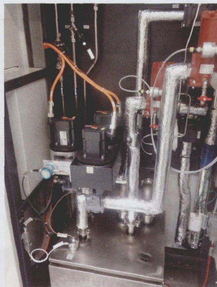
凯本隆 VA-214 液位传感器集成了双重监测功能, 在高温环境下, 同时实现精确的液位和温度监控, 完美地满足了客户的应用需求
