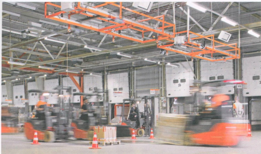
图1 叉车把包裹卸到地面车辆上，装在结构框架上的系统进行采集数据
