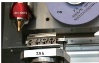
图7 AMBIT激光堆焊头在Mill Grind机床上修复导流片座
