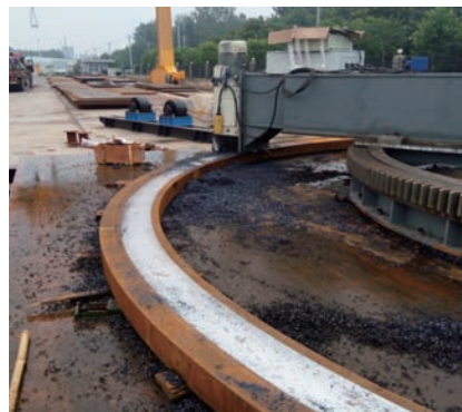
图4 正在加工的环形轨道
