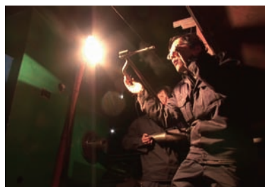
图5 采用找正摇杆对镗杆进行校正
