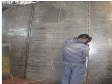
图3 纵缝焊接操作图
