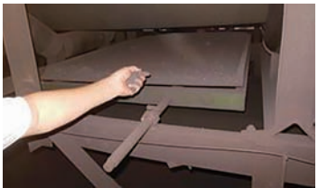
图7 支撑框架现场安装图
