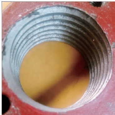
图8 手工加工的螺纹孔
