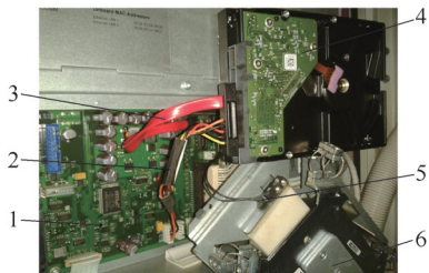
(c) 硬盘更换现场
