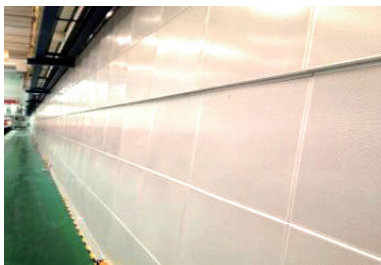
(a) 穿孔板墙体结构
