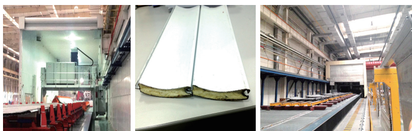
(a) 卷筒端门 (b) 卷筒端门组成结构 (c) 以往端门结构 图5 端门结构
