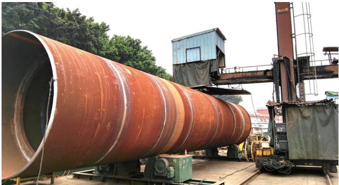
图2 桩腿埋弧焊接
