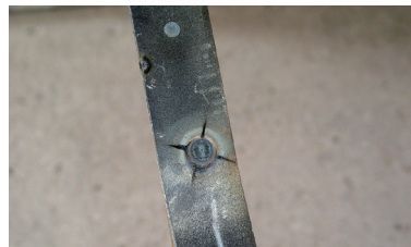
图2 焊缝中心有缩孔和裂纹
