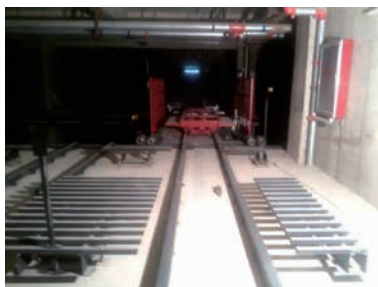
图8 梳板应用实景 两人从中间向两端焊接。④每道焊缝焊完后，应及时将焊缝表面
