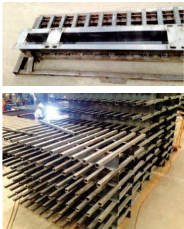
图7 在工装组装和定位焊接的梳板
