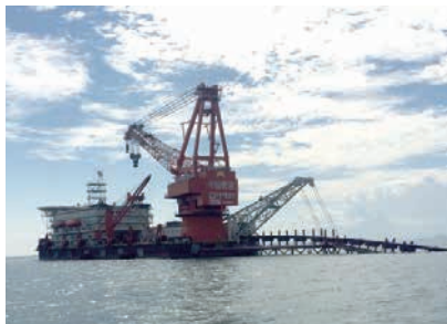
图1 海管铺设现场
