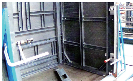
图9 箱体框架大组装
