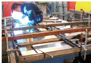
图8 箱体侧板组装
