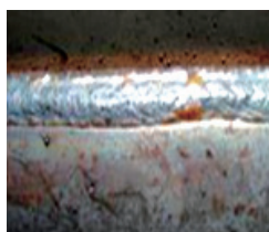
图5 试板3焊缝外观
