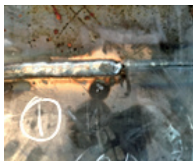
图2 试板1焊缝外观
