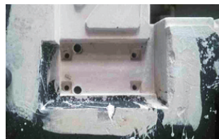
图6 溢流瓷管的实施
