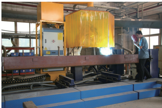
图4 焊接机器人工作站焊接纺丝箱箱体
