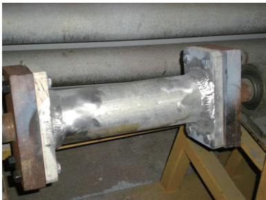
图12 焊接完成后焊缝状态
