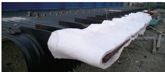
图3 中厚件焊后缓冷措施
