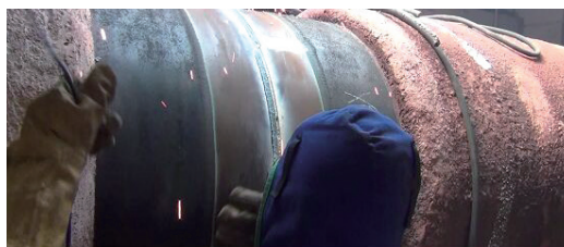
图6 管道焊接现场
