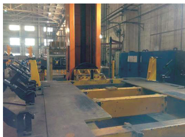
图2 实际反变形样板安装
