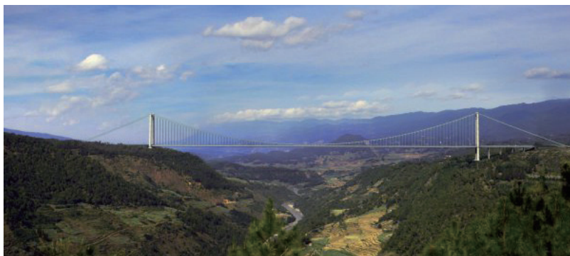
图1 龙江大桥主桥概貌
