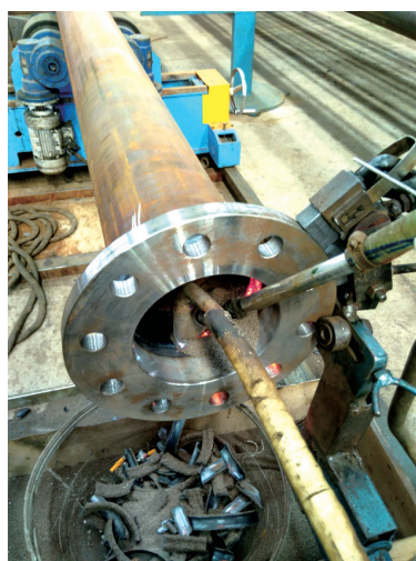
(d)内侧焊缝焊接
