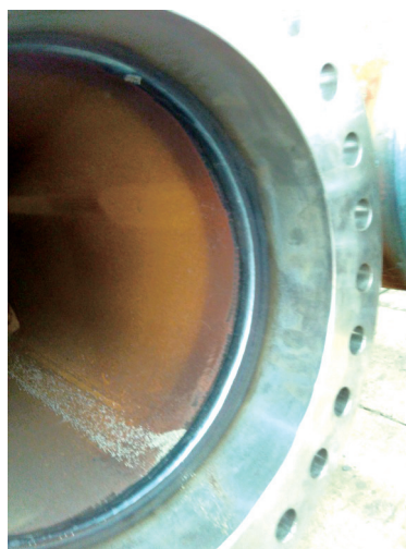
(b)环焊缝内侧形貌
