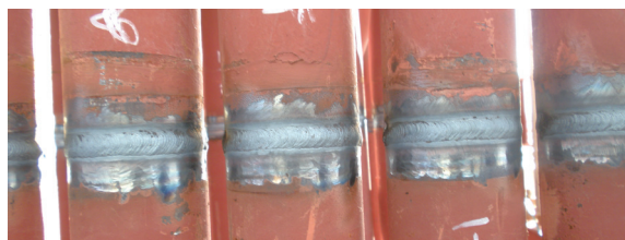
(a) 水平固定焊口外观
