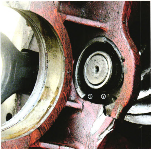
图1 减速器壳导向轴承座孔断裂图
