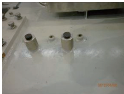
(b) 测温管外部
