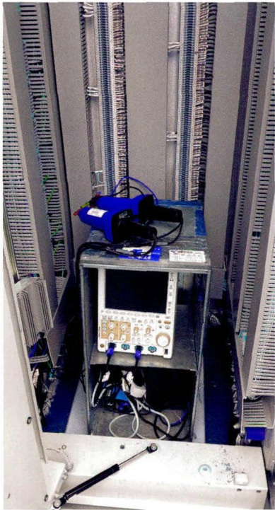
图1 测量系统现场照片
