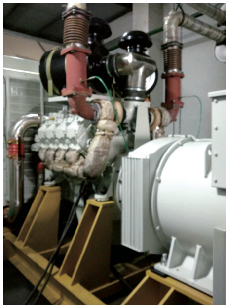
图3 实物保护系统柴油发电机
