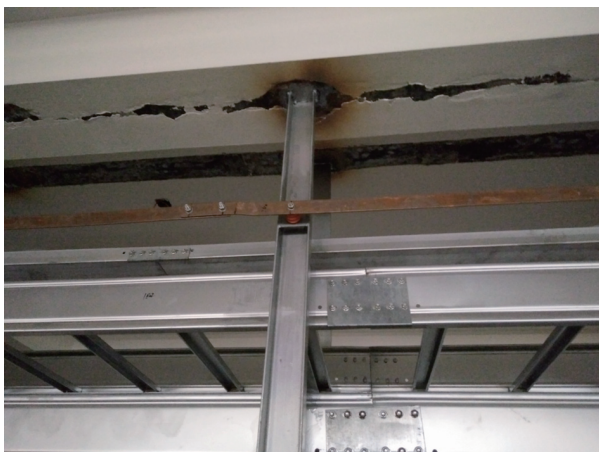
图2 电缆夹层内等电位接地网做法
