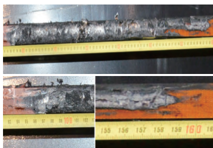
图2 第二处烧损具体情况
