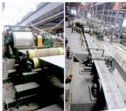
图5 调试阶段现场图片
