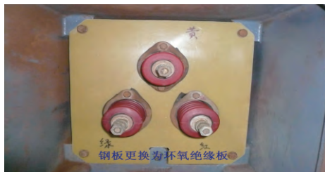
图3 接线柱底板更换
