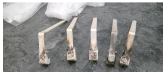
图2 被电弧烧灼后的直流断路器触头
