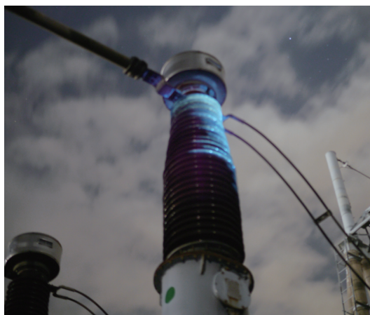
图5 开关CT B相检测结果
