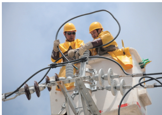
图1 带电作业施工现场
