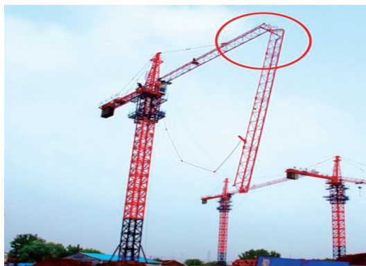
图2 某事故中雷击造成起重臂折断
