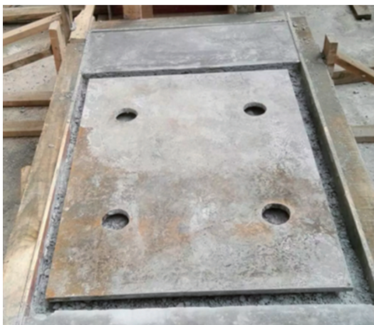
图4 支撑钢板局部二次灌浆
