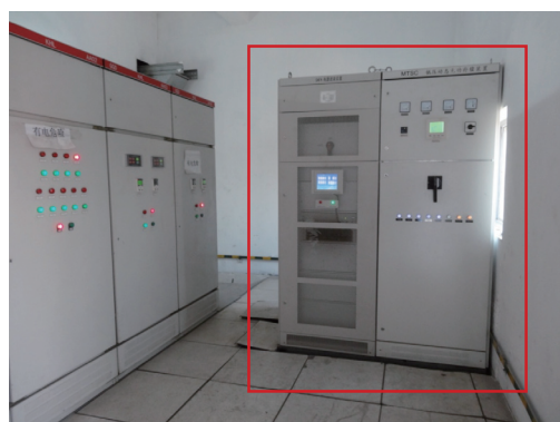
图5 现场安装后照片
