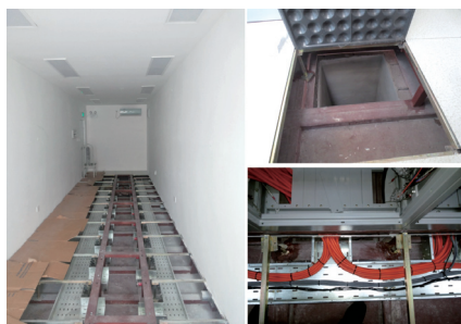
图10 预制舱内电缆、光缆连接
