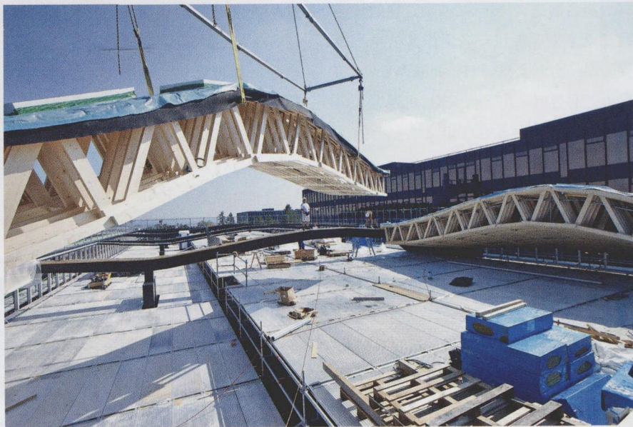
图 2 现在，数字化、机器人生产开拓出木结构生产领域无法想象的可能性。如果不是使用机器人进行生产，ETH 苏黎世建筑技术研究院 (ITA) 便不可能经济地实现 Arch Tec Lab 建筑物木结构屋顶的生产
