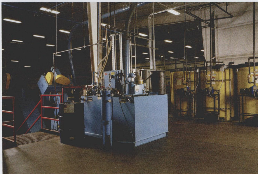
图 2 将冷却液循环系统安装在切屑脱水系统上方的地板上
