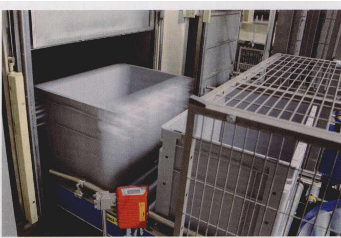
图5 输送容器定期的在高架仓库中运动
