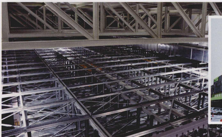
图1 高度大约 15 m 的自动化小件仓库每一排货架的长度为 70 m。共有六条可供 BOXer E1 自动存取机高架叉车行走的通道
